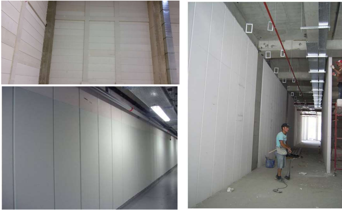
Görsel 3: Gazbeton Donatılı Paneller Yangın Duvarı.
